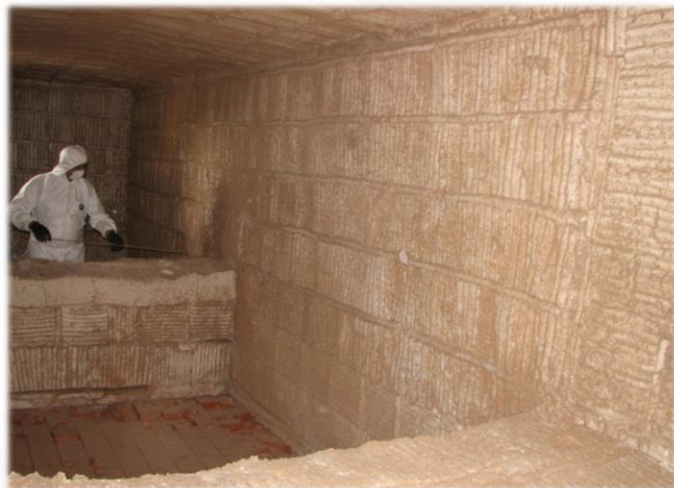
Remise en état des incinérateurs COV
